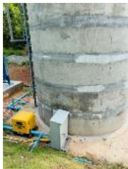
ตู้ควบคุมระบบไฟฟ้าปั๊มน้ำติดตั้งในตำแหน่งที่ไม่เหมาะสม ได้ทำการย้ายออกจากบริเวณดังกล่าวแล้ว
