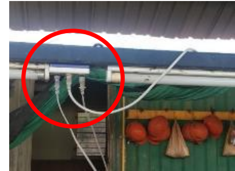
อุปกรณ์ปลั๊กไฟที่ติดตั้งบริเวณโรงล้างถ่านหินไม่ได้ มาตรฐาน โดยใช้ปลั๊กที่มีราคาถูกไม่ได้คุณภาพ ซึ่ง ประสานงานให้ทำการเปลี่ยนเรียบร้อยแล้ว
