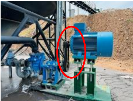
มอเตอร์ถังสูบลมไม่มีการครอบจุดหมุน ได้ทำการแจ้งไปทางผู้รับผิดชอบให้ดำเนินการติดตั้งการครอบแล้ว
