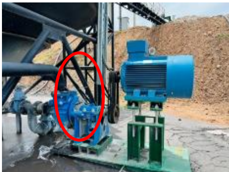
มอเตอร์ถังสุบลูเลนไม่มีการครอบ ทางผู้รับผิดชอบได้ดำเนินการติดตั้งการครอบเรียบร้อยแล้ว
