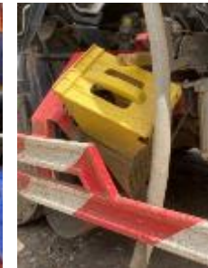
อุปกรณ์ปลั๊กไฟที่ติดตั้งบริเวณโรงล้างถ่านหินไม่ได้ มาตรฐาน โดยใช้ปลั๊กที่มีราคาถูกไม่ได้คุณภาพ ซึ่ง ประสานงานให้ทำการเปลี่ยนเรียบร้อยแล้ว
