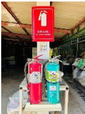
ถังดับเพลิงที่ใช้ในอาคารได้เพิ่มประเภทที่เหมาะสมในการดับเพลิงประเภทงานไฟฟ้าเพื่อความปลอดภัยในการทำงาน
